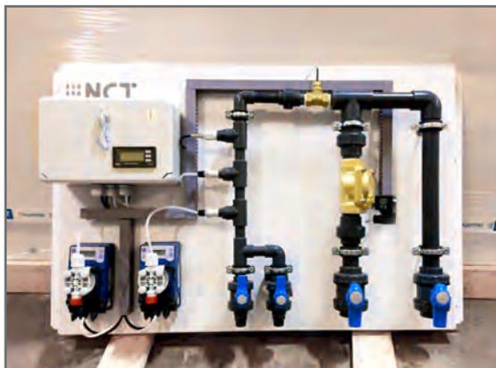
**Контрольная панель ХВП** - электронная система водоподготовки, предназначенная для контроля качества воды в системе оборотного водоснабжения путем пропорционального дозирования ингибитора накипи/коррозии и биоцида.
